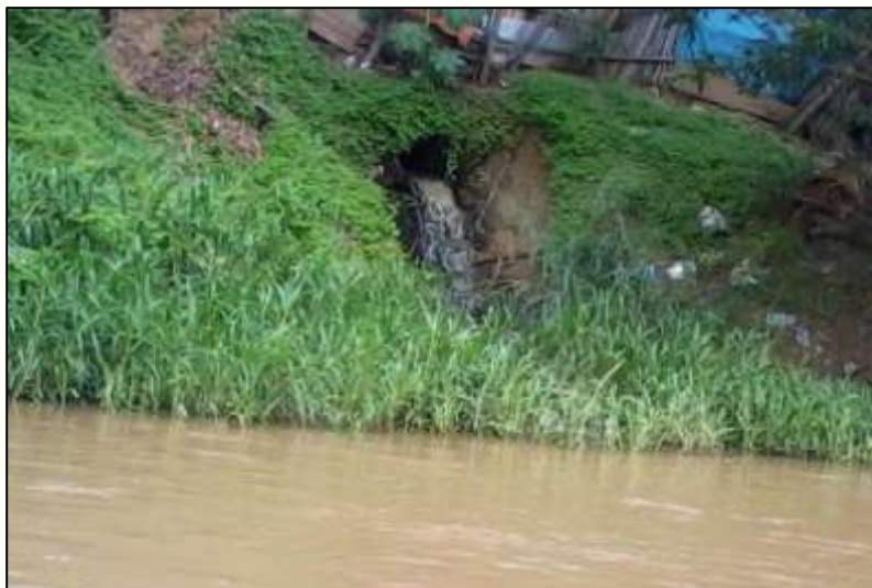
Figura 7. Lançamento de esgoto in natura no rio Mearim
