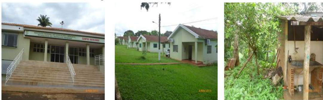
Figuras 2 a 4 – Vista do IFTM e residências onde as ovitrampas estão instaladas, fevereiro/2013. Fotos: João Carlos de Oliveira.
