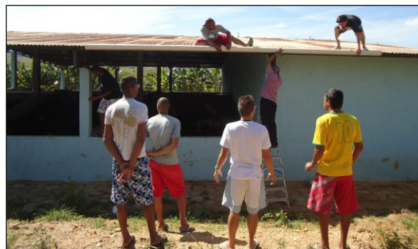
Figura 2 – Aula prática de instalação de calha para captação da água da chuva (APAC São João del-Rei, ano de 2015)
