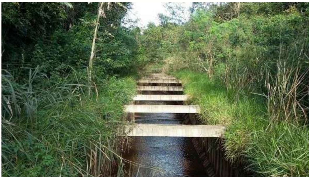
Figura 1: Parte do Córrego Canalizado no Parque
